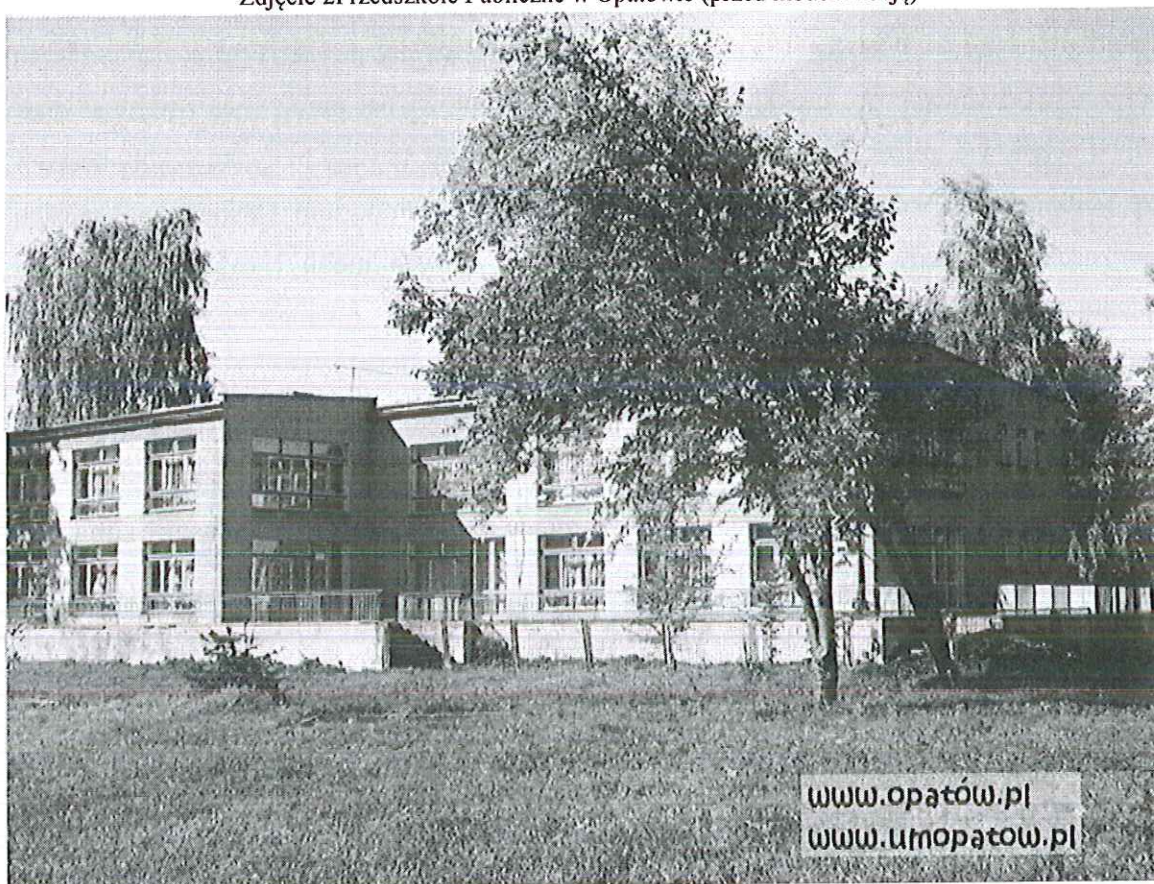
Zdjęcie 2Przedszkole Publiczne w Opatowie (przed modernizacją)
