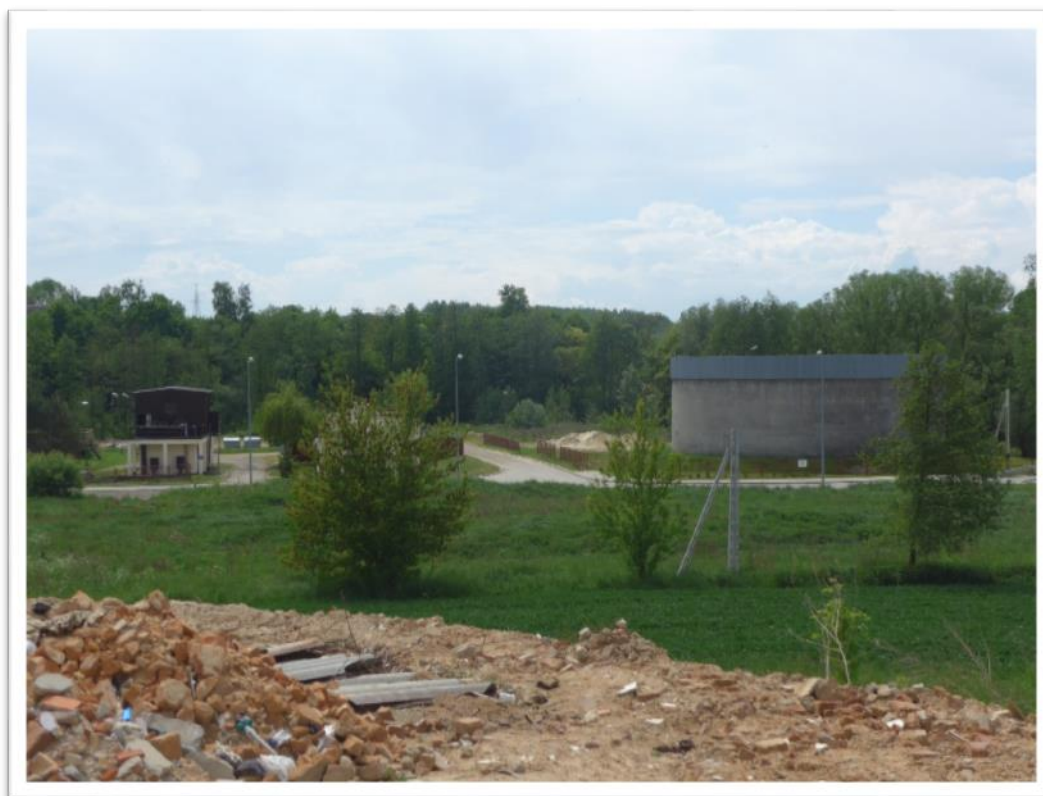
Zdjęcie 3 Oczyszczalnia ścieków w Opatowie – stan obecny.
